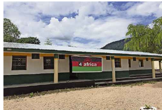
Das Schulhaus mit vier Klassenzimmern. Jedes davon ist mit neuen Schultischen und Bänken ausgestattet worden.
